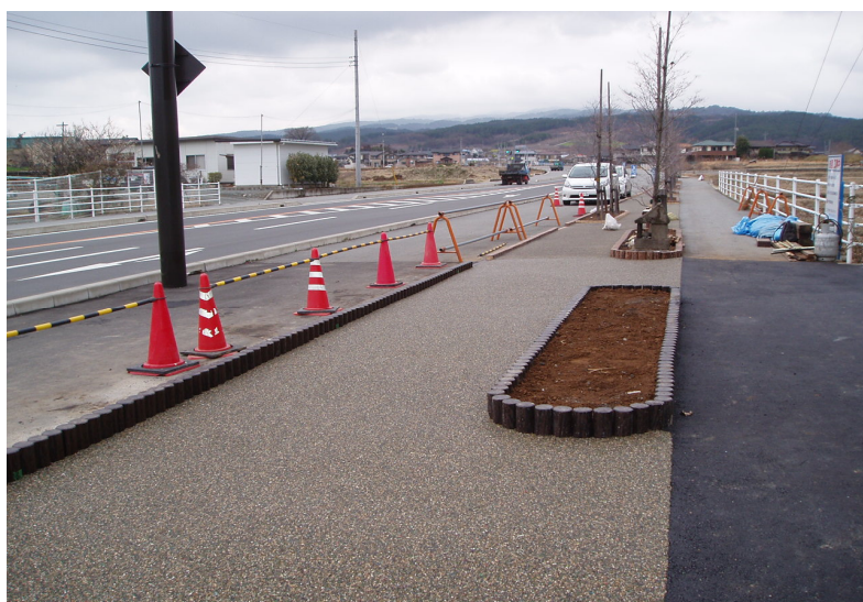
県道島上条線 H17、H19年施工
